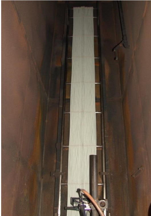
Abbildung 2: Montage eines Kabelprüfkörpers Figure 2: Mounting a cable test specimen
