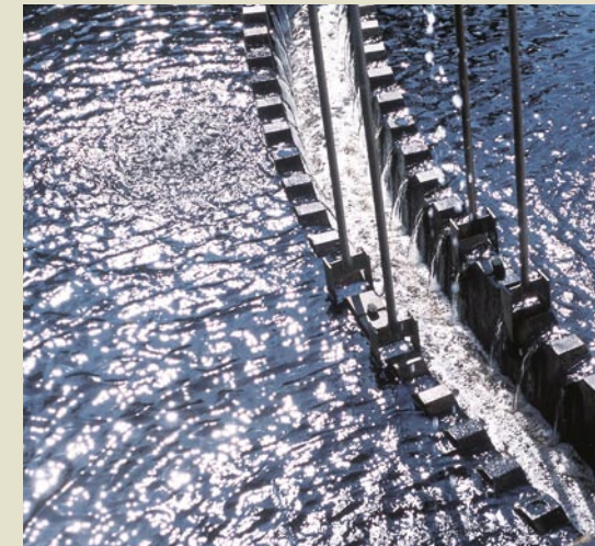
Teil der Abwasserbehandlungsanlage in Krefeld-Uerdingen.
