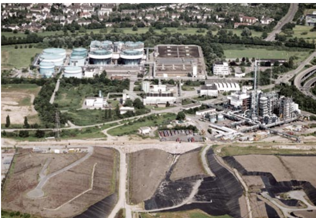
Das Entsorgungszentrum in Leverkusen-Bürrig aus der Luft.
