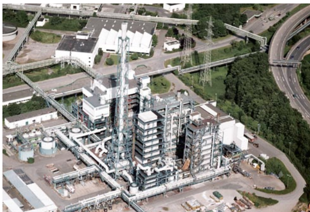
Die Verbrennungsanlagen für feste, flüssige und wässrige Abfälle in Leverkusen-Bürrig.
