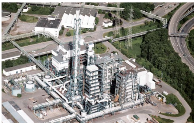
Gli impianti per l'incenerimento di rifiuti solidi, liquidi e acquosi a Leverkusen BÜrrig.
